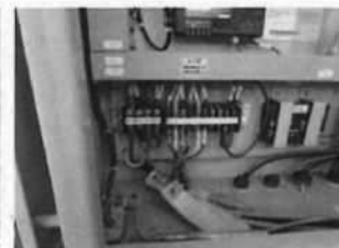
水管理システムの故障、 FOMA 終了による通信不能
