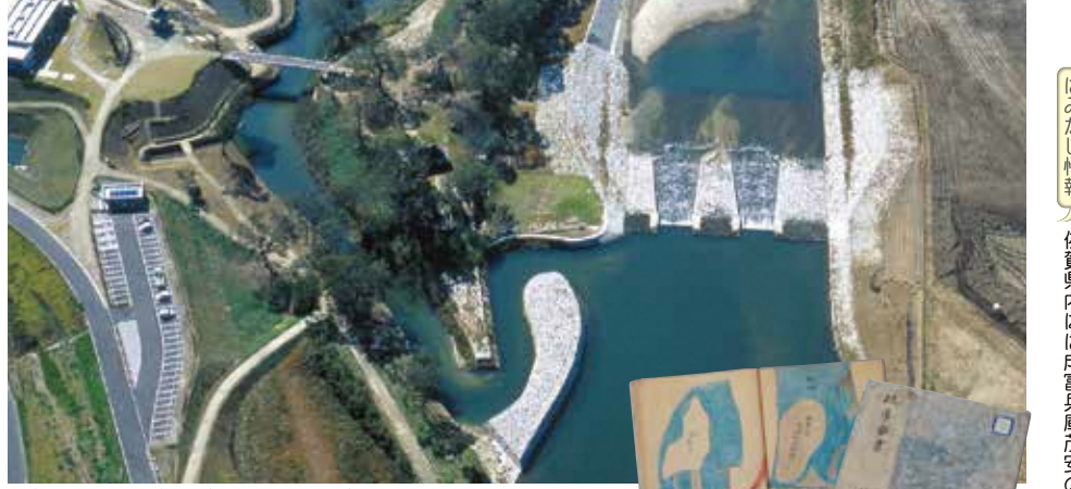
▲嘉瀬川から佐賀城下へ水を取込む巨大取水施設「石井樋」その完成により、洪水被害は減り、佐賀城下の水不足は解消された(画像提供:筑後川河川事務所)
