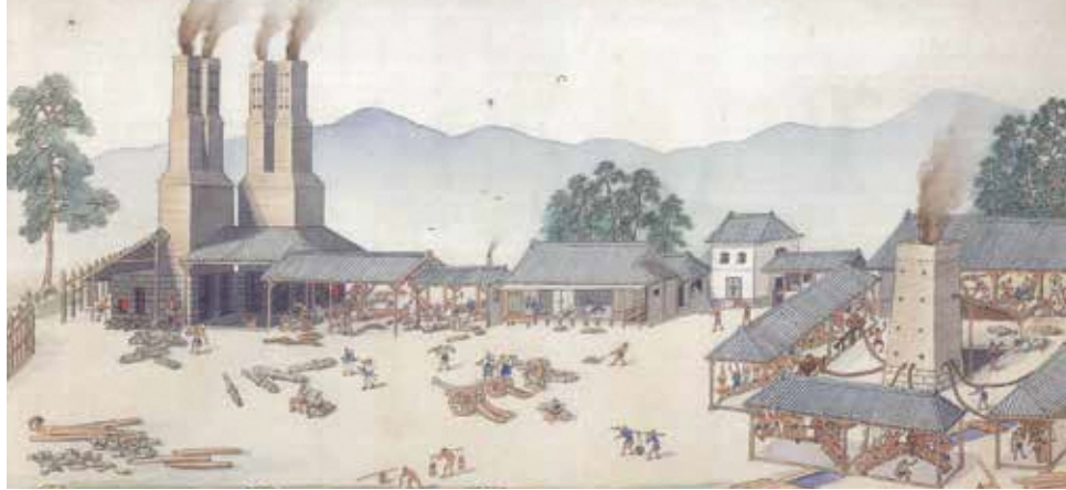
▲「築地反射炉絵図」(鍋島報効会蔵) 直正が鉄製大砲製造のために築地(ついで)今の佐賀市長瀬町に作らせた日本初の反射炉。後に幕府からの大砲の注文に応えるため、市内の多布施にも作られた
