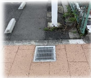
排水施設(集水ます)
