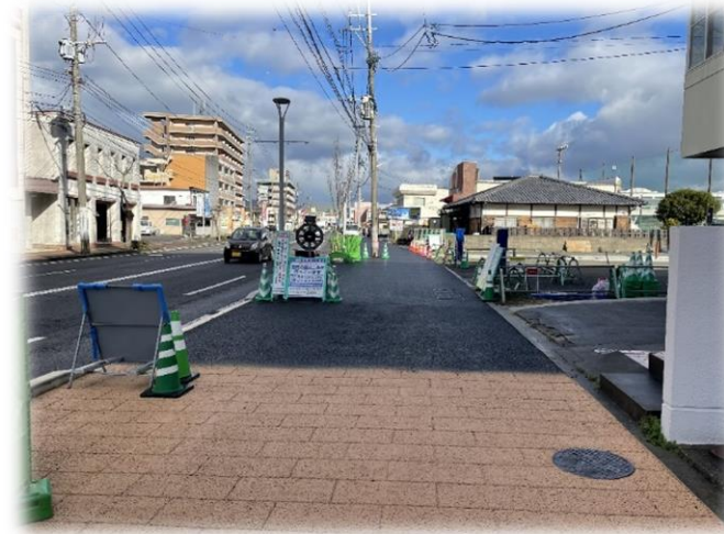
△市道三溝線（整備中）
