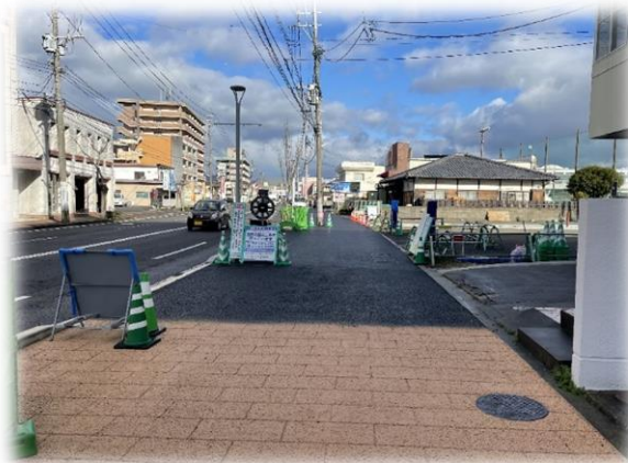
写真2. 市道三溝線(整備中)
