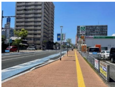
整備完了区間
