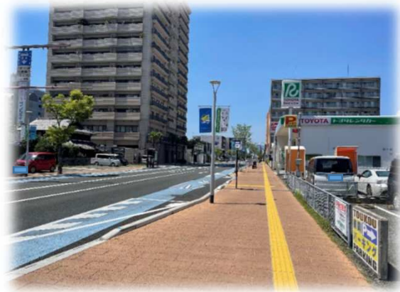
写真1. 市道三溝線(整備後)
