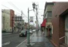
バナーフラッグ付きの 照明灯を設置
