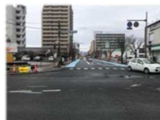
【道路整備の状況】
