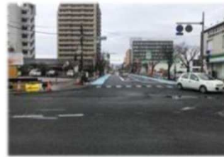
【道路整備の状況】
