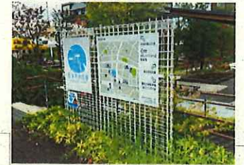
溶接金網・虎溪用水広場
