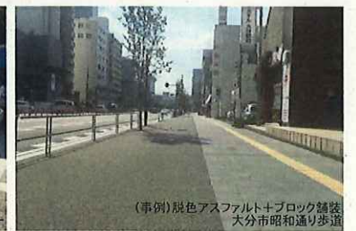
(事例) 脱色アスファルト舗装 + 自然石ポーター
