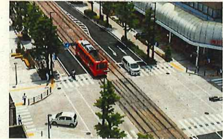
■ 交差点部舗装のイメージ: 強度的に優れる半たわみ性舗装を用いた事例
