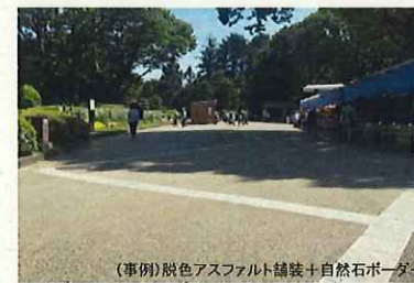
(事例) 脱色アスファルト舗装 + 自然石ポーター
