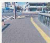
▲プリント舗装
