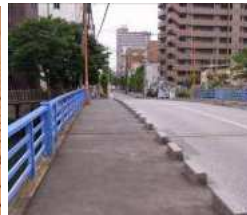
▲アスファルト舗装
