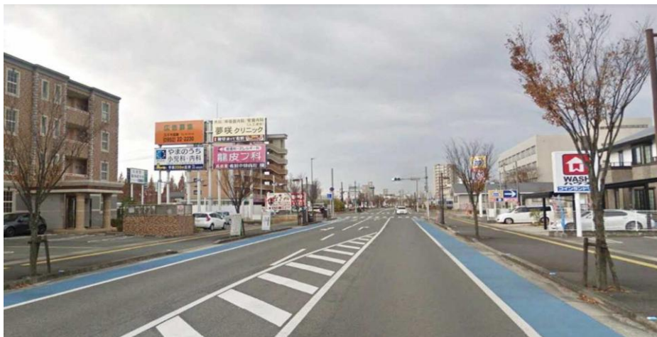
【参考事例】市道江頭西湊線(佐賀市兵庫北:幅員20m)
