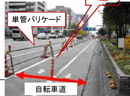
▲東側に自転車道を仮設
