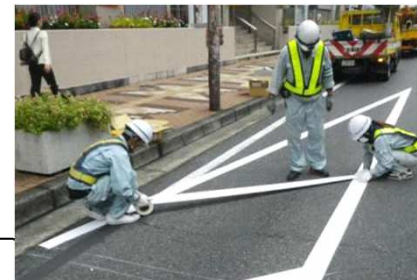
▲テープで区画線を仮設
