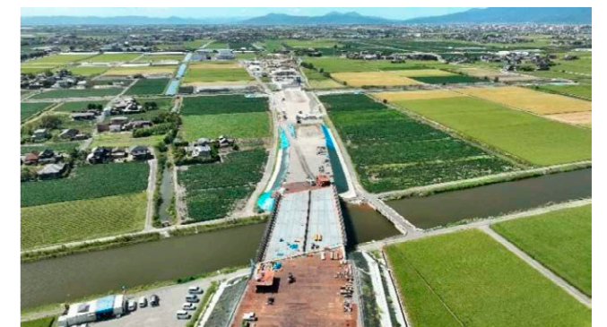
図表 1-2 有明海沿岸道路の工事の様子
