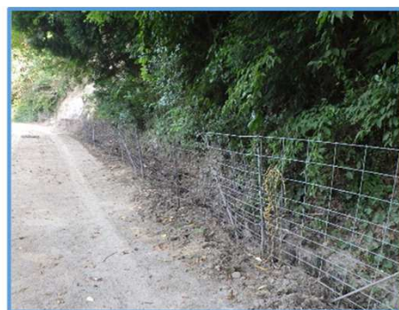
【復旧後】防護柵を再度取り付け、短期間で復旧することができました。
