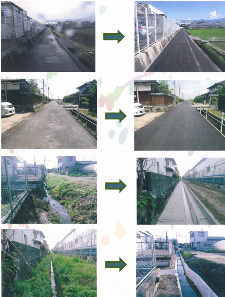
改修前の道路・水路
