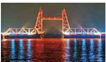
▲ブルーライトアップされた昇開橋
