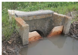
▲田んぼに切れ込みのあるせき板を設置。396 haで実施(25 mプール1,320杯分を貯留)
