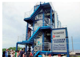
▲佐賀大学海洋温度差発電施設
